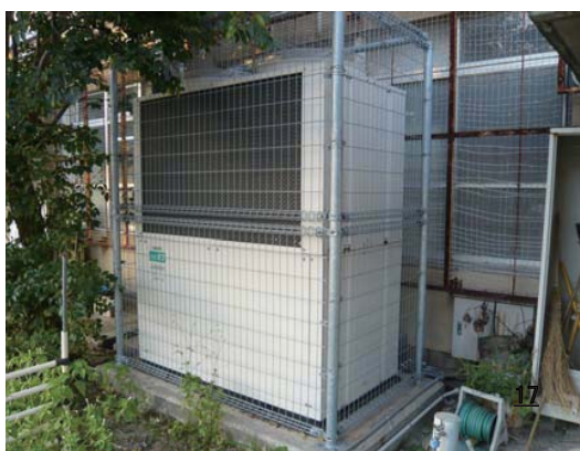
GHP 15 (ガスエンジンヒートポンプ)
