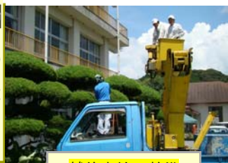
補修点検・整備
