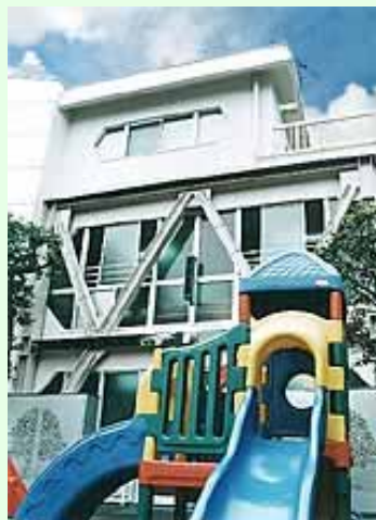
耐震補強後の園舎外観(鉄骨ブレースの設置) (東京都:伸びる会幼稚園)
