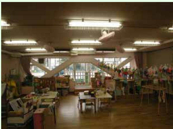
耐震補強後の保育室(鉄骨ブレースの設置) (東京都:台東区立富士幼稚園)
