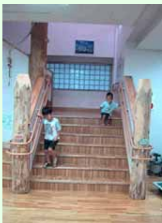
幼児の成長に配慮したユニバーサルデザイン による階段の手すり (東京都:台東区立石浜幼稚園)
