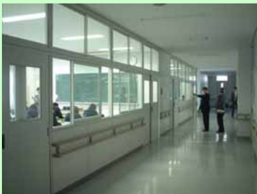
障害のある生徒や教員、保護者等 のために設けられた廊下の手すり (東京都:東京都立科学技術高等学校)
