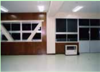
耐震補強後の 特別教室
