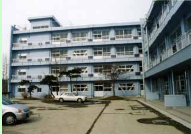
耐震補強後の校舎外観(鉄骨ブレースの設置) (宮城県:宮城県立涌谷高等学校)
