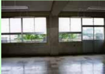
耐震補強前の 特別教室
