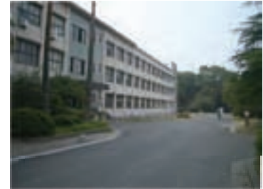
老朽化した施設
