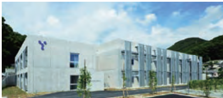
燃料電池の研究開発拠点となる施設を整備
