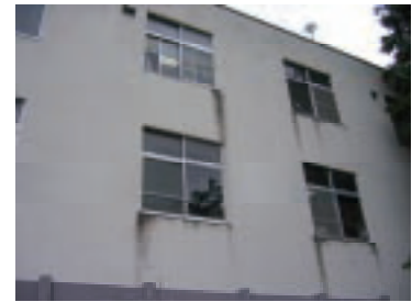
外壁の劣化による雨水侵入等、教育研究に支障
