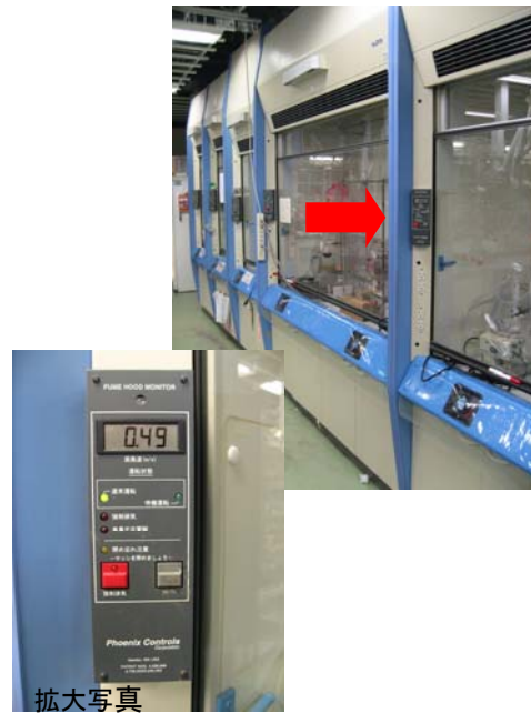
面風速を表示し、可変風量制御されているドラフトチャンバー。
