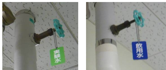
誤認しないよう系統が表示されている
