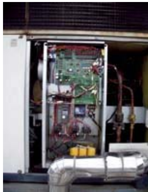
室外機内部のスイッチを操作するだけで静音モードに設定可能
