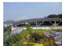
完成した屋上緑化
