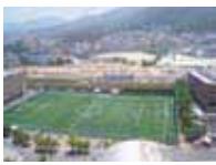
透水性グラウンドの設置
