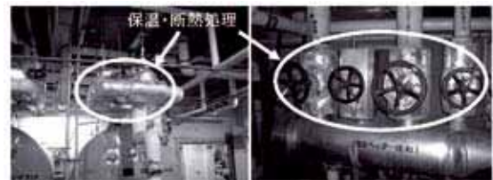
配管・バルブ断熱処理
