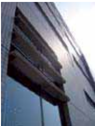
外壁・窓のひさし
