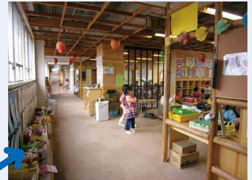
写真 8a-2 廊下との間仕切りを撤去（改修後）
