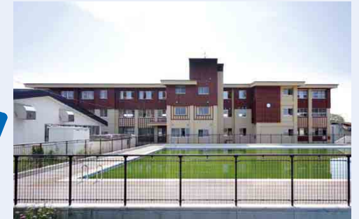
写真 10a-2 外観 (改修後)
