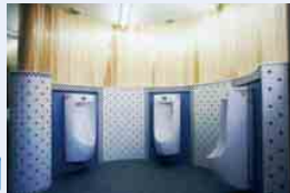
写真 9a-2 男子トイレ (改修後)
