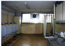
写真 9a-1 男子トイレ内部 (改修前)
