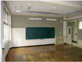
写真 1a-1 余裕教室（改修前）
