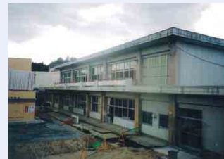
写真 10b-1 外観 (改修前)
