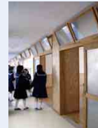
写真 4a-1 廊下側の間仕切り通気性を高めた教室
