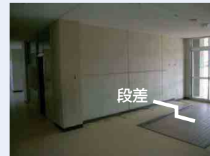
写真 2a-1 昇降口（改修前）
