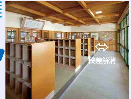
写真 2a-2 昇降口（改修後）
