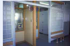
写真 9a-4 トイレ入り口 (改修後)
