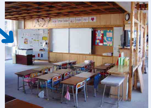
写真 8a-3 内装を木質化（改修後）
