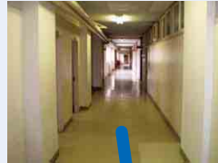
写真 5a-3 廊下 (改修前)
