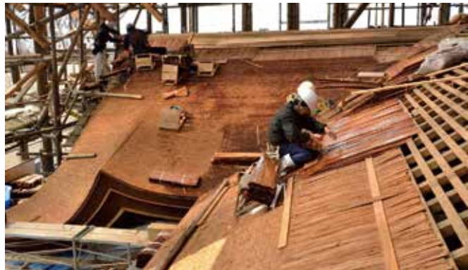
国宝清水寺本堂屋根施工の様子（京都府）
