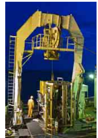
ボーリング調査風景
