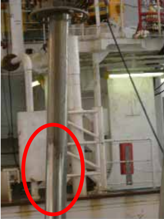
写真-3 表面コーティングの剥離が進行し、シリンダーロッド上部の表面コーティングが剥離 (赤線で囲んだ部分)(5月22日)
