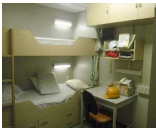
定員増(200人化)工事
