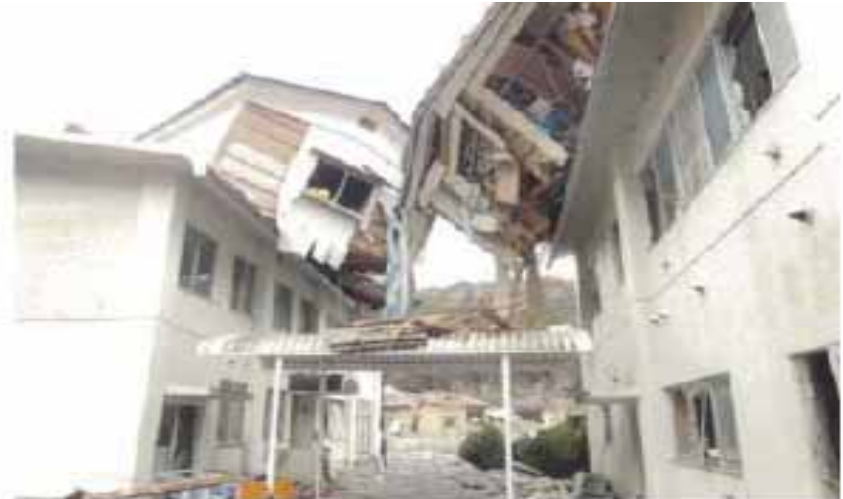
○東北大学 複合生態フィールド教育研究センター 被害： センター棟の屋根部に流出民家が乗り上げ
