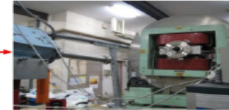
9階 地震横揺れによるイオン源装置の損壊 (真空排気装置は全損)
