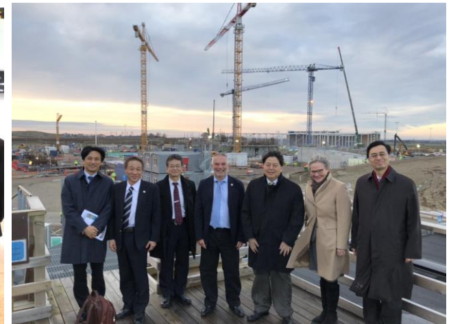
ESS建設予定地にて
