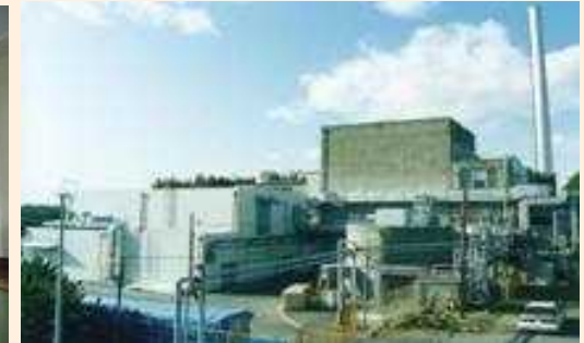
解体中の原子力施設
