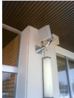
小学校、児童館の玄関に設置したノド(センサー)でセンシング
