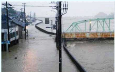
出典：平成23年台風第12号による熊野川（三重県）の越水状況（国土交通省）
