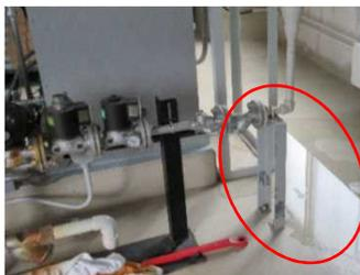
電磁弁付近の雨漏りによる水たまり
