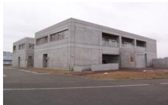
兵庫県放射光 ナノテク研究所 (H20) ※先端科学技術支援センターⅢ期施設 《約4億円》
