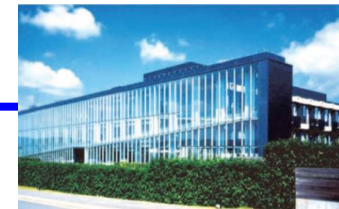
兵庫県立大学 高度産業科学技術研究所 ※先端科学技術支援センターⅡ期施設 (H10(H24~大学移管)) 《約50億円》
