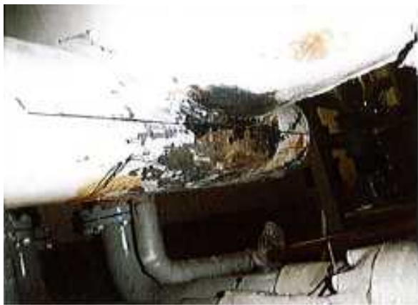
腐食した装置
