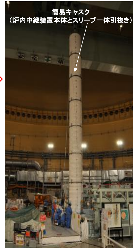
簡易キャスク(耐熱性)を使用し落下した炉内中継装置本体と燃料出入孔スリーブを一体で引き抜いた
