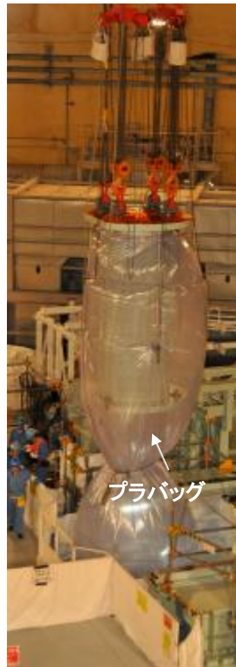
プラバッグ(塩ビシート)を使用し炉上部大型機器を取外した
