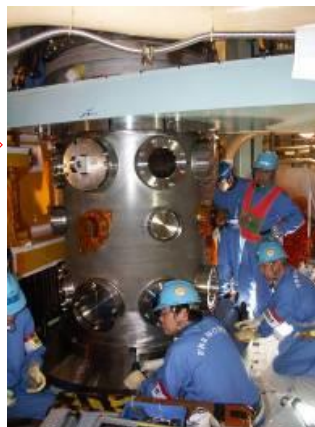
仮設治具によって作業中のカバーガスバウンダリを確保した
