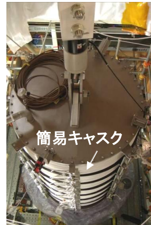
引き抜き作業前の状態
