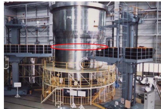
大型部材の高品質溶接
