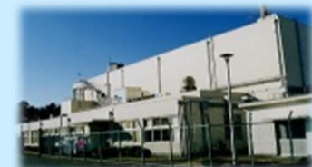
照射燃料試験施設
