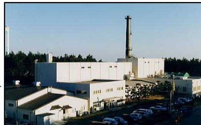
照射材料試験施設 (MMF)
