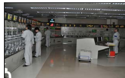
全交流電源喪失時プラント操作訓練
