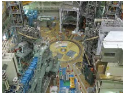
解体終了 (H24.10)
