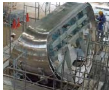
真空容器実機40° セクター1体目完成
