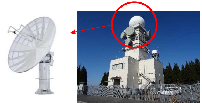
《観測施設》CバンドMPLレーダ雨量計
