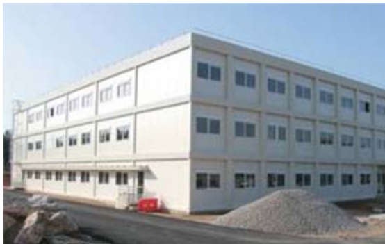
(←)2008年11月 ITER本部ビル開所
