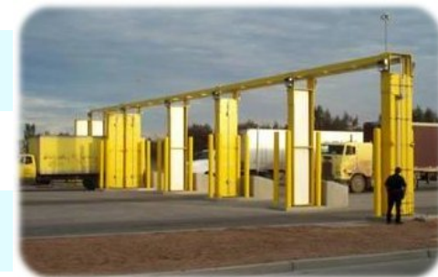
コンテナ内核検知装置
