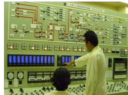
蒸発処理装置・IIのコントロールパネル
