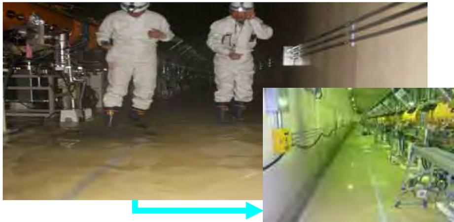
加速器トンネル内が地下水により10cm浸水
