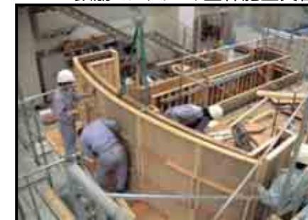
鉄筋コンクリート型枠施工実習
