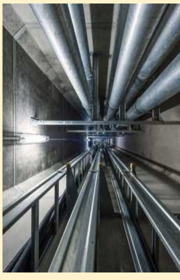
ライフラインの更新により、停電による研究成果の消失や配管破損による危険物の流出を防止
