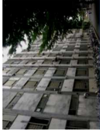
外壁・サッシの落下の危険
