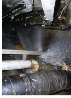
配管の破損による水漏れ
