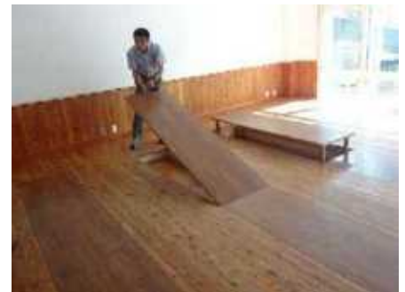
▲保育室の床に収納できるテーブルを設け、用途にあわせて活用している。
