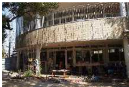
▲新館のエントランス、1階は厨房。
