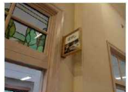
▲各保育室の入口欄間部分には、その組をイメージしたスタンドグラスを配している。
