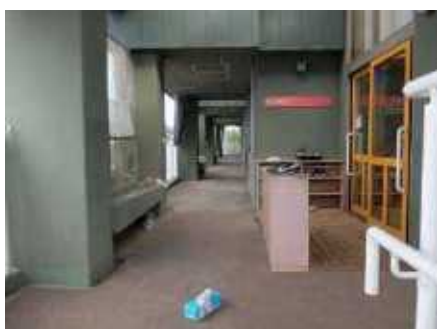
▲各教室に直接アクセスする半屋外の外廊下。
