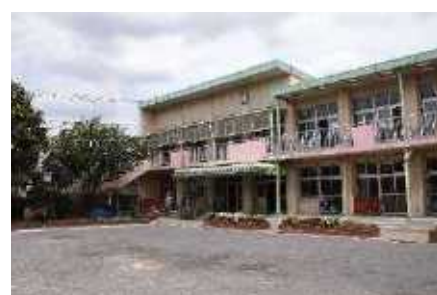
▲園庭から園舎を臨む。園庭と保育室が連続した空間として機能。
