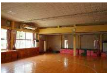
▲多目的に使用可能なホール。
