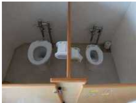
▲家庭には大人用便座しかないことを考慮して、大人用便座と子供用便座両方を設置。
