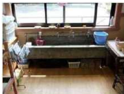
▲保育室内の流し。人研ぎは建設当時のものを活かして利用している。
