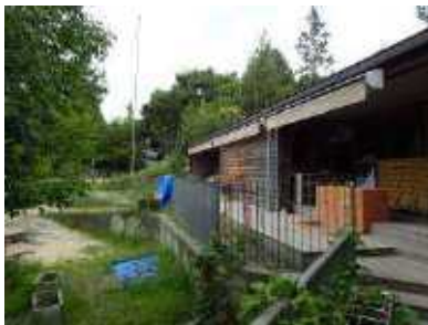
▲ウッドデッキが保育室と園庭を繋ぐ装置となっている
