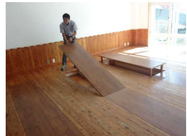
▲保育室の床に収納できるテーブルを設け、 用途にあわせて活用している
