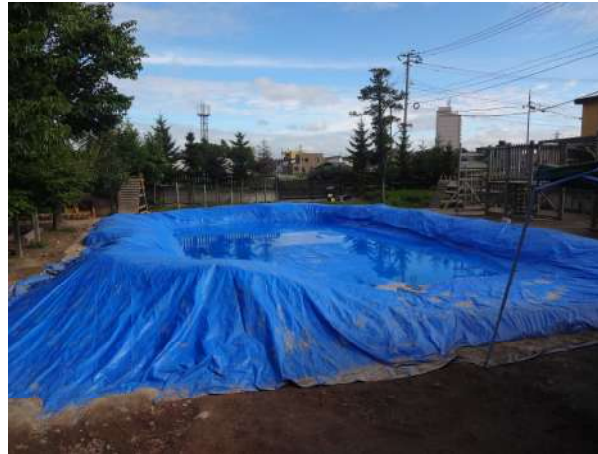
▲夏の間、園庭に重機で穴を掘り、ビニールシートを敷いてプールにし、秋が来たら埋め戻す
