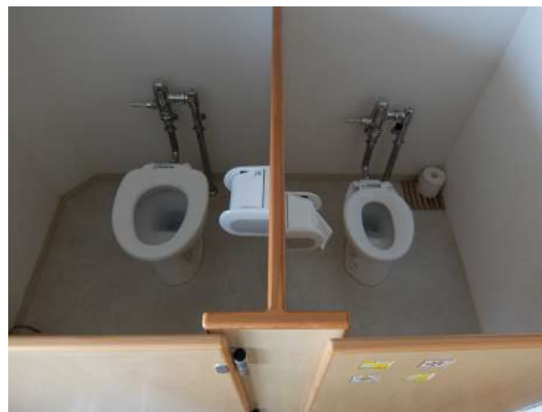
▲大人用便座と子供用便座両方を設置
