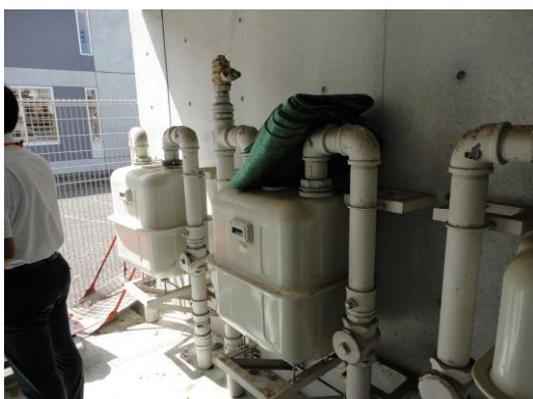
通常は都市ガスを使用しているが、災害時にはプロパンガスが使用できるよう、ガス変換機の接続口を配備。
