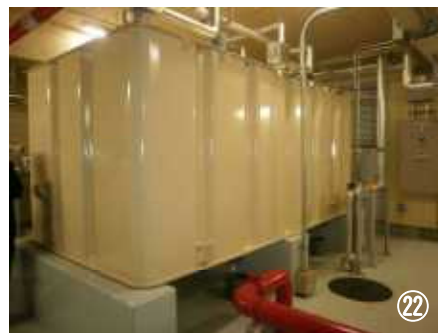
▲体育館に隣接して設置された受水槽。非常時には、タンクから直接採水することができる。
