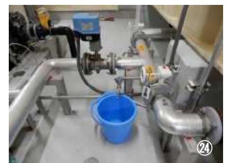
▲体育館に隣接して設置された受水槽。非常時には、タンクから直接採水することができる。
