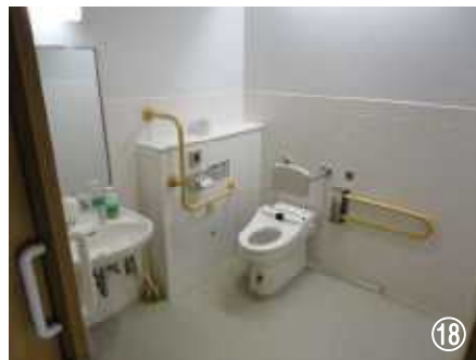
▲多目的トイレ。
