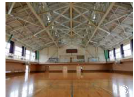
▲体育館（小学校）。
