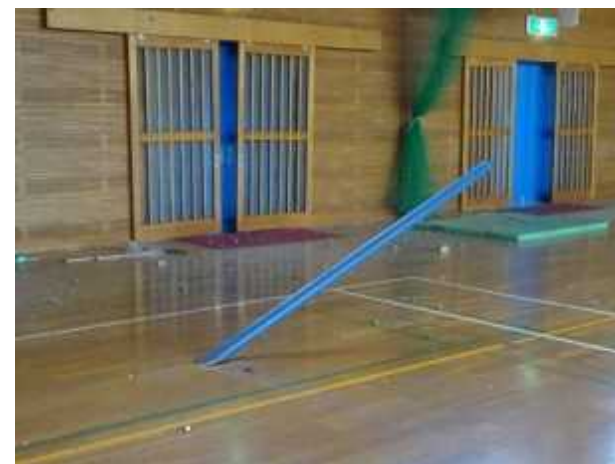
体育館の床に突き刺さった屋根構造材（熊本高校）
