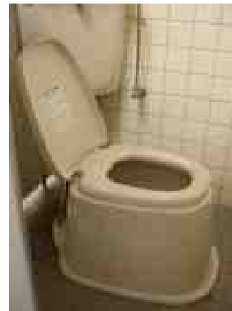
和式便座の上に設置された 簡易洋式トイレ
