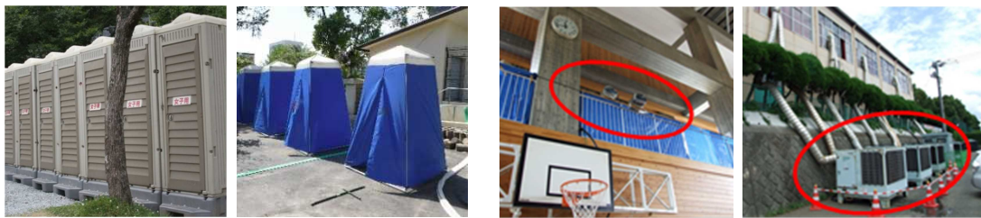
トイレ（左：仮設トイレ、右：マンホールトイレ） 汲取りの処理、照明、和式等の問題があり、マンホールトイレの設置を求める声があった。
