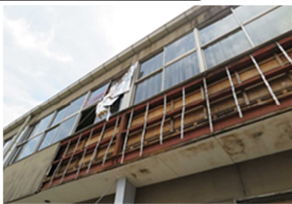
<経年劣化したラスモルタルによる外壁（湿式外壁）の落下（体育館）>
