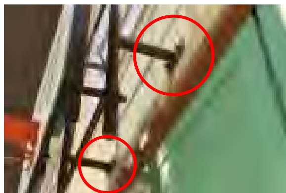
写真2. 体育器具の取付部の例
