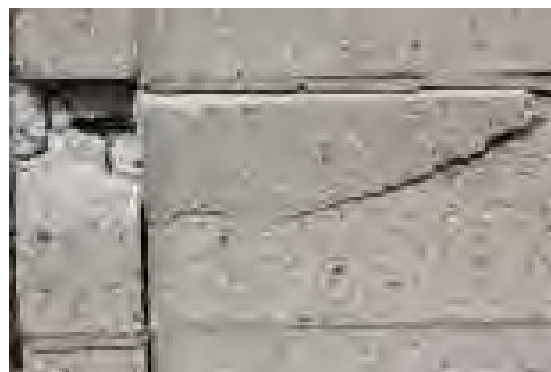
写真2. コンクリートブロックの欠損、ひび割れ
