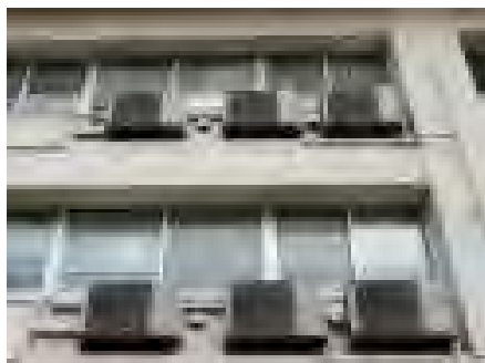
写真1. 上階に設置された空調室外機
