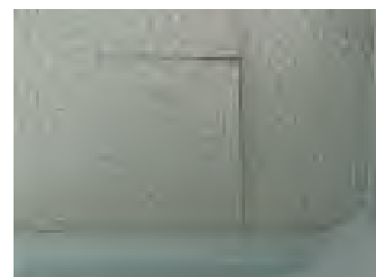
写真2. 天井材のずれ
