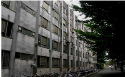
外壁・建具落下の危険
