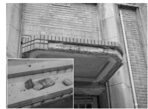
▲外壁タイルの剥落
