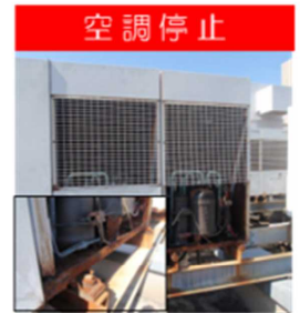
空調停止 ■空調機 経年23年内部部品が腐食したため、温度調節ができない状態。
