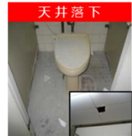
天井落下 ■床スラブ 経年31年上階の便器固定用モルタルの落下により、天井を突き破り床まで落下。
