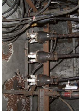
老朽化した変電設備 (停電・火災の危険性あり)
