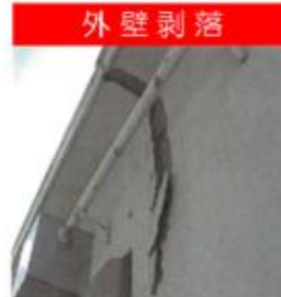
■外壁 経年46年外壁が経年劣化により亀裂を生じ剥落。
