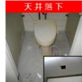
■床スラブ 経年31年上階の便器固定用モルタルの落下により、天井を突き破り床まで落下。
