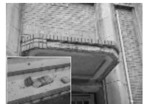
▲外壁タイルの剥落
