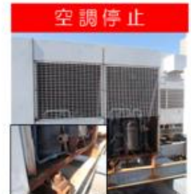
■空調機 経年23年内部部品が腐食したため、温度調節ができない状態。
