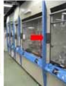
送気量を表示し、可変換気量制御されているドラフトチャンパー
