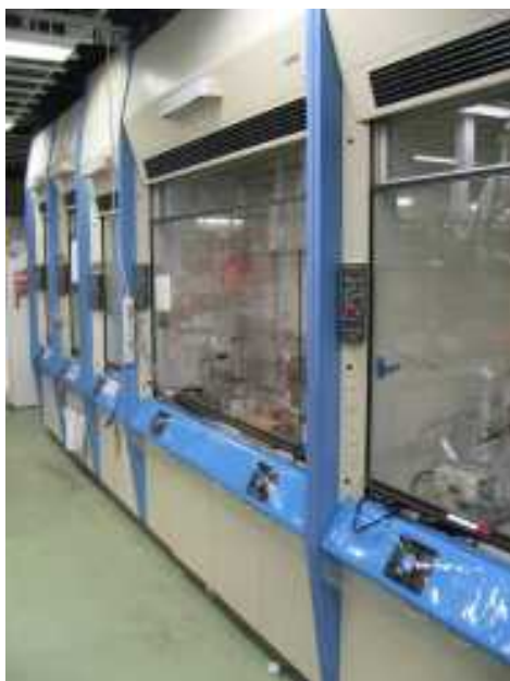
面風速により、可変風量制御されているドラフトチャンバー
