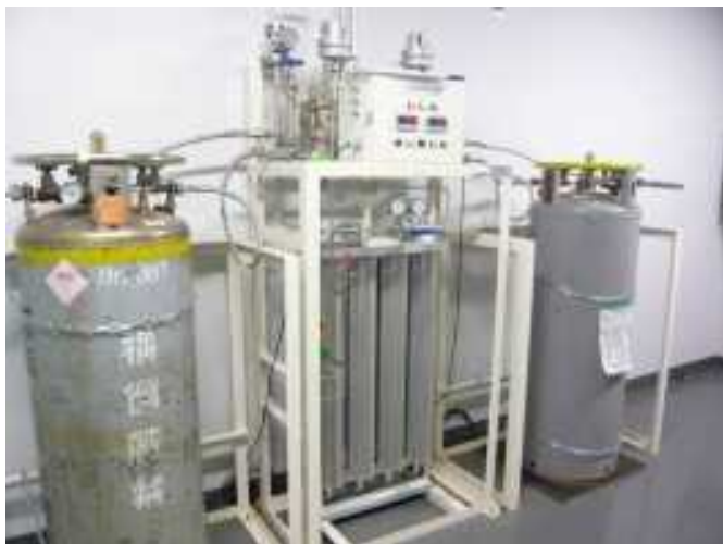
ボンベ庫内で液化アルゴンを蒸発させ、中央配管方式でアルゴンガスを供給している例
