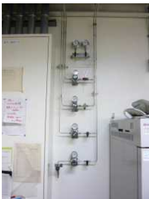
高圧ガスの供給を中央配管方式とした例
