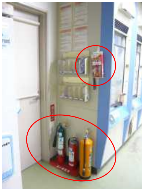
使用する物質に合った消火ができるよう数種類の 消火器等を設置
