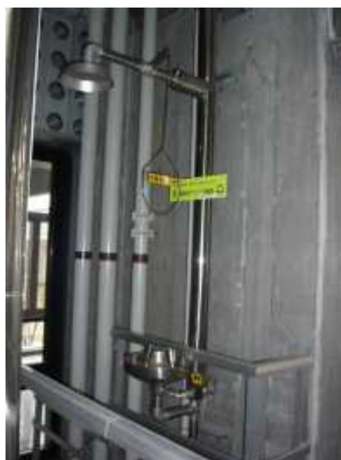
緊急シャワーと洗眼装置を一体的に設けた例（設置場所については要検討）
