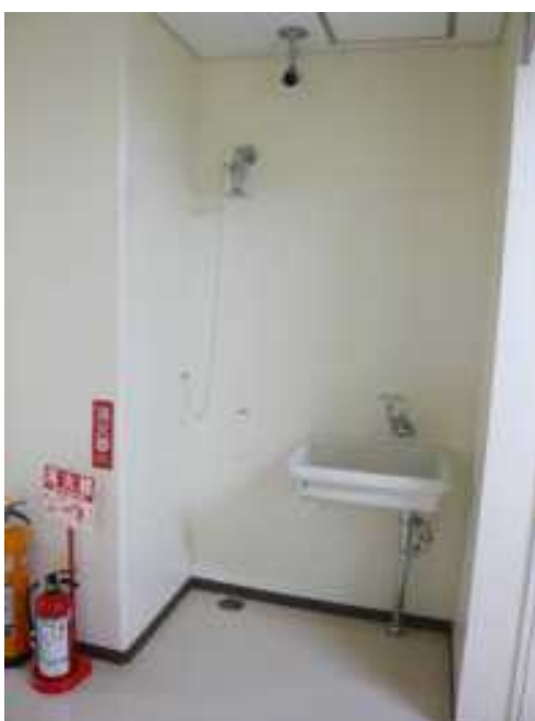
廊下の一部に緊急シャワーと洗眼装置を設置
