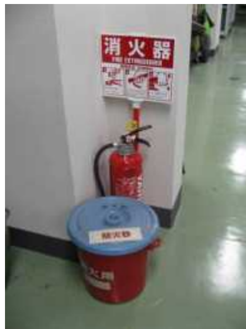
粉末消火器と防火砂を設置
