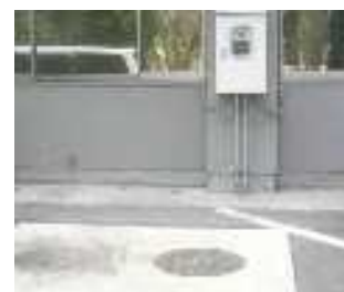
地中に設置されたモニター槽と外壁に設置されたPH監視装置
