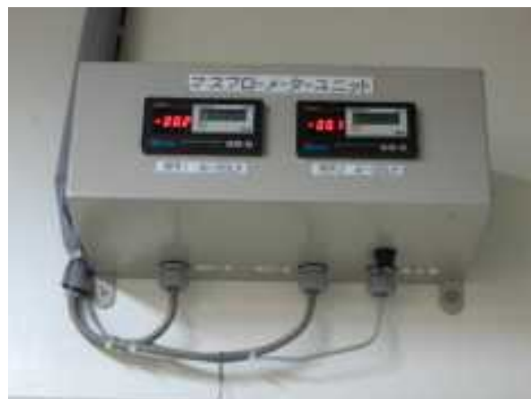
各実験室ごとにガスの計量メーターを設置
