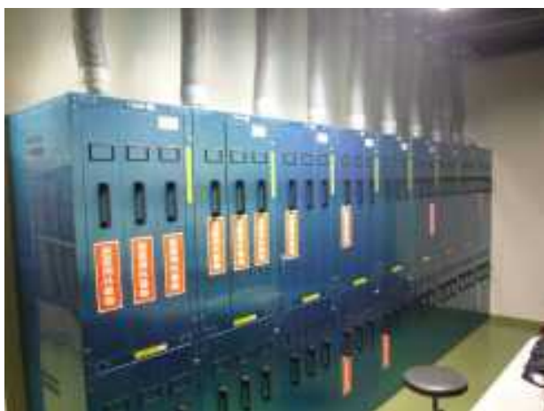
毒物・劇物は貯蔵室内の専用保管庫で管理
