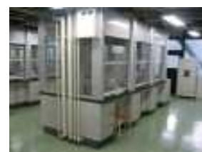
実験台全体を廃棄フードで多い 化学物質等のばく露を防止
