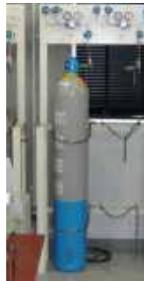
2点で固定されたボンベ
