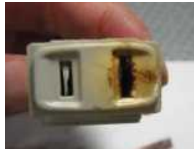
トラッキング火災により燃焼したコンセント
