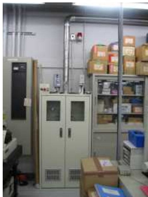
可燃性ガスはシリンダーキャビネット内に設置
