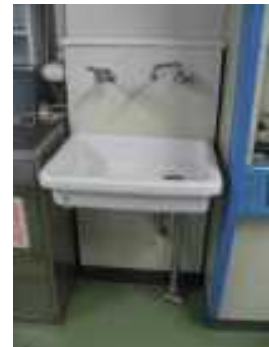
洗面器と洗眼装置を一体的に設置
